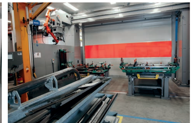
Alle onderdelen voor een wand, bodem of dakdeel worden compleet op een verzamelaar aangeleverd.
