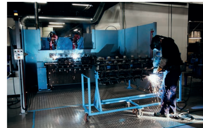
Während der Bediener auf den Roboter wartet, führt der Schweißer in der Zwischenzeit einen manuellen Schweißvorgang aus.
