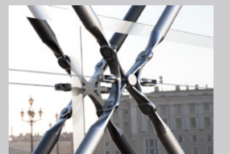
Eine der Komponenten, die Robotik Toolbox für das niederländische Ingenieurbüro Dura Vermeer gedruckt hat, ist ein Prototyp einer „Stahlspinne“ - einem Connector zur Befestigung von Glasvliesfassaden an Stahlkonstruktionen. www.autodesk.com
