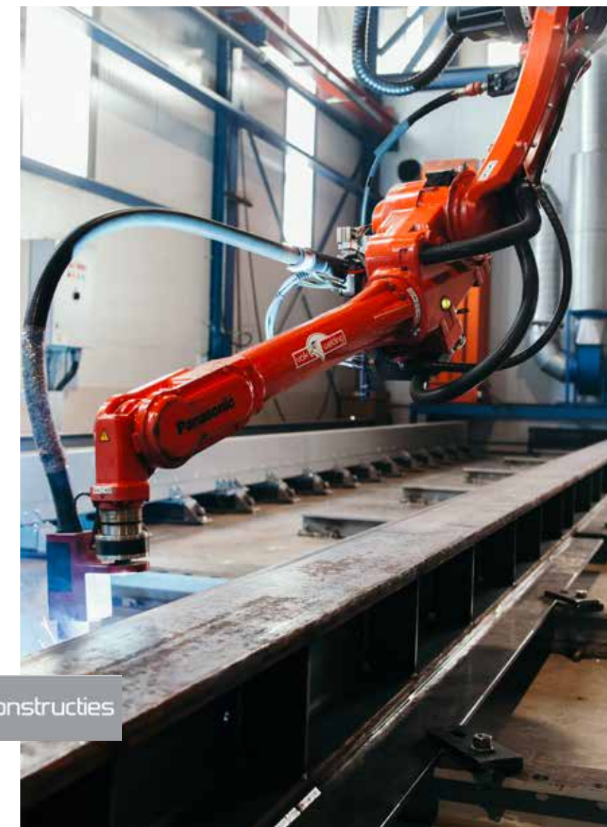
Robotten svejser nu 15 m lange SFB-komposit stålkonstruktioner på 3 timer
