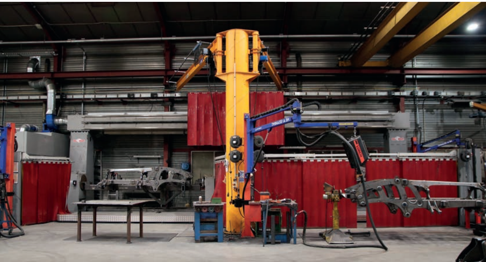
De eerste cel ontwikkeld door Valk Welding voor Comebo Industries is gebaseerd op een hangende robot aan een portaal, voor afmetingen tot 5 meter in plaats van 3,2 meter met de vorige machine.
