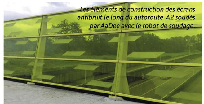
Les éléments de construction des écrans antibruit le long du autoroute A2 soudés par AaDee avec le robot de soudage.
