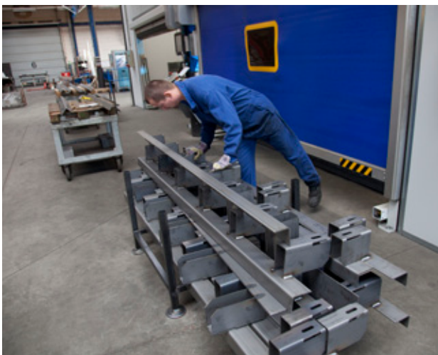
Die Stützen werden ohne Vorfixierung auf die Träger geschweißt.
